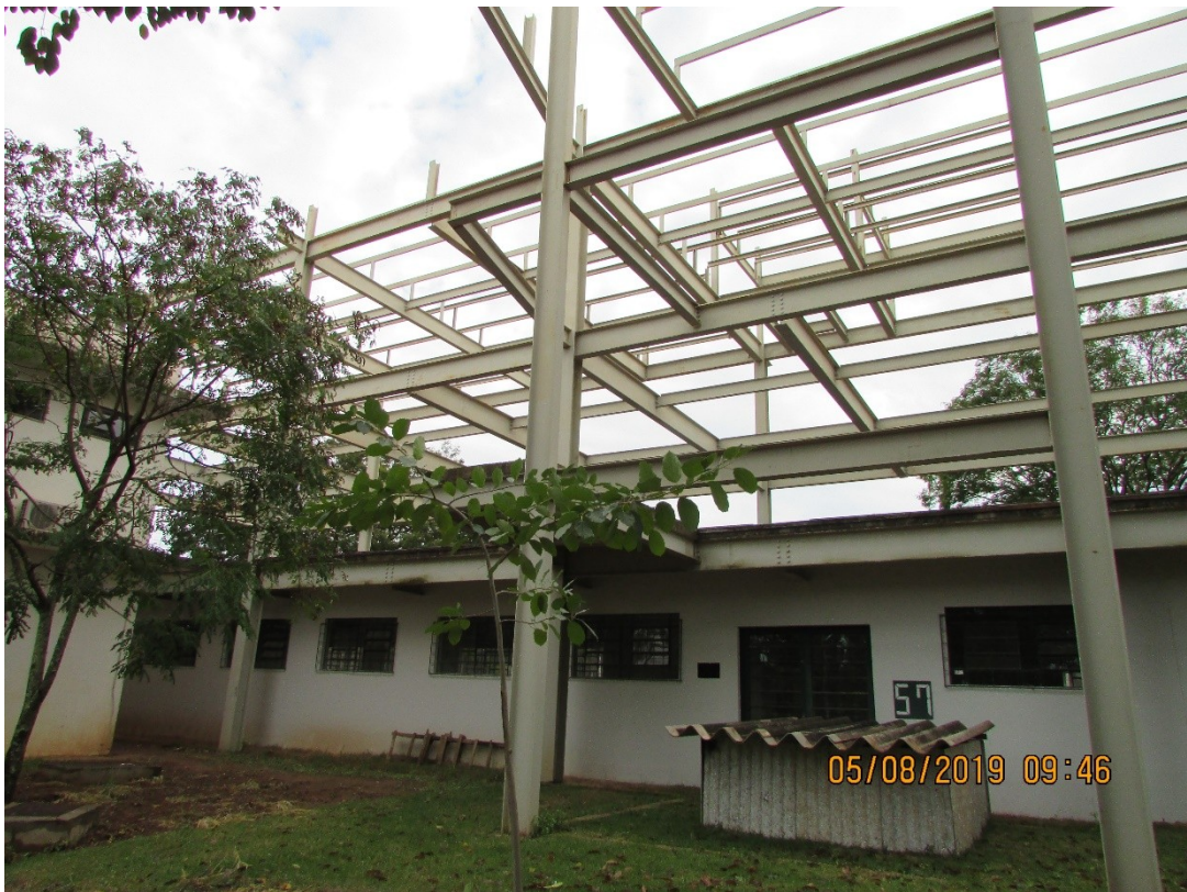
Foto 9: Cobertura da caixa do fosso e drenagem externa.
