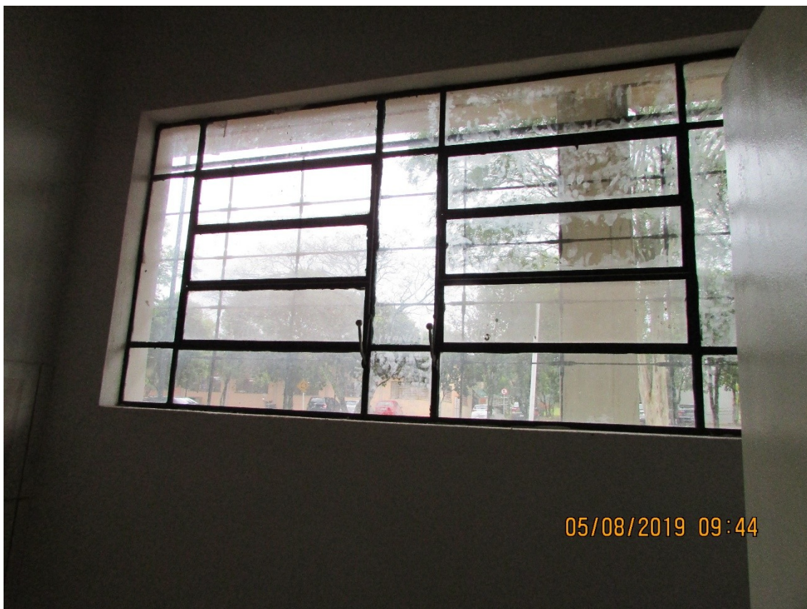
Foto 5: Recuperação das aberturas e colocação de vidros.
