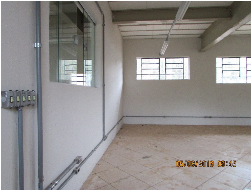
Foto 6: Recuperação de pisos danificados e rede elétrica.
