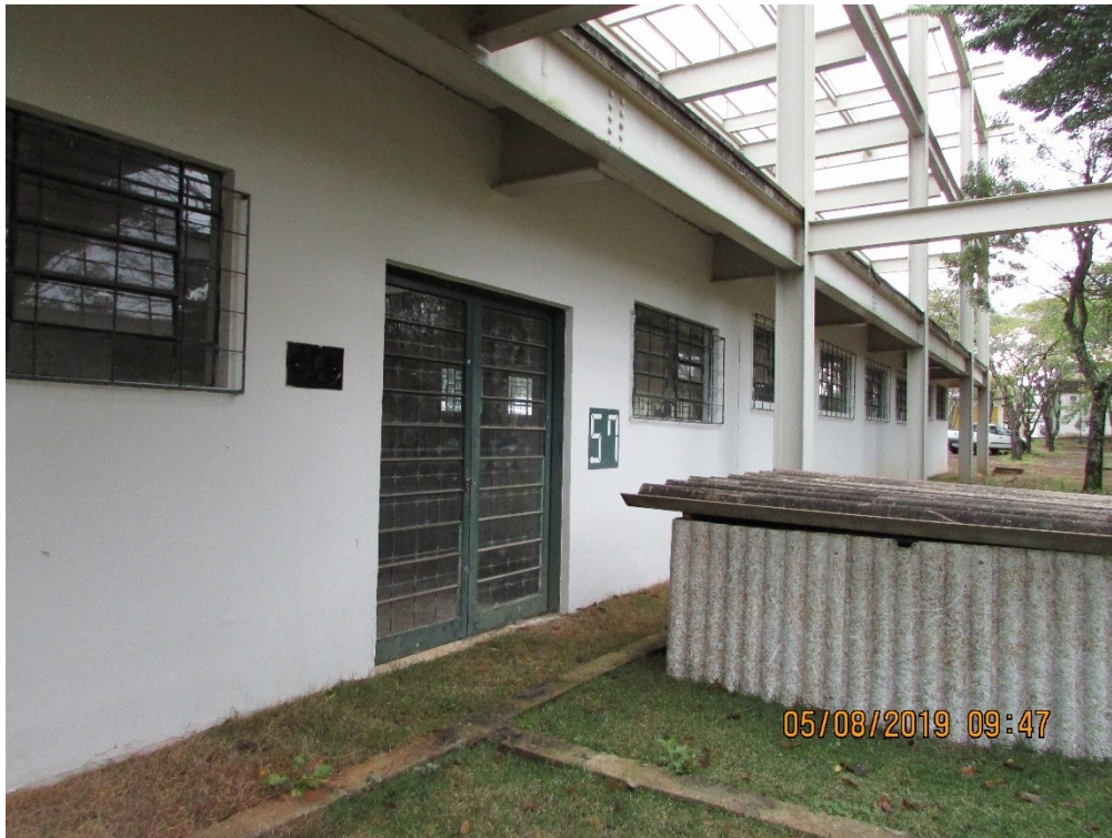
Foto 10: Pintura e drenagem externa.
