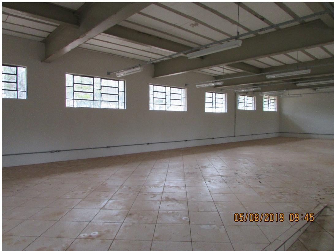
Foto 7: Recuperação de pisos danificados e rede elétrica.
