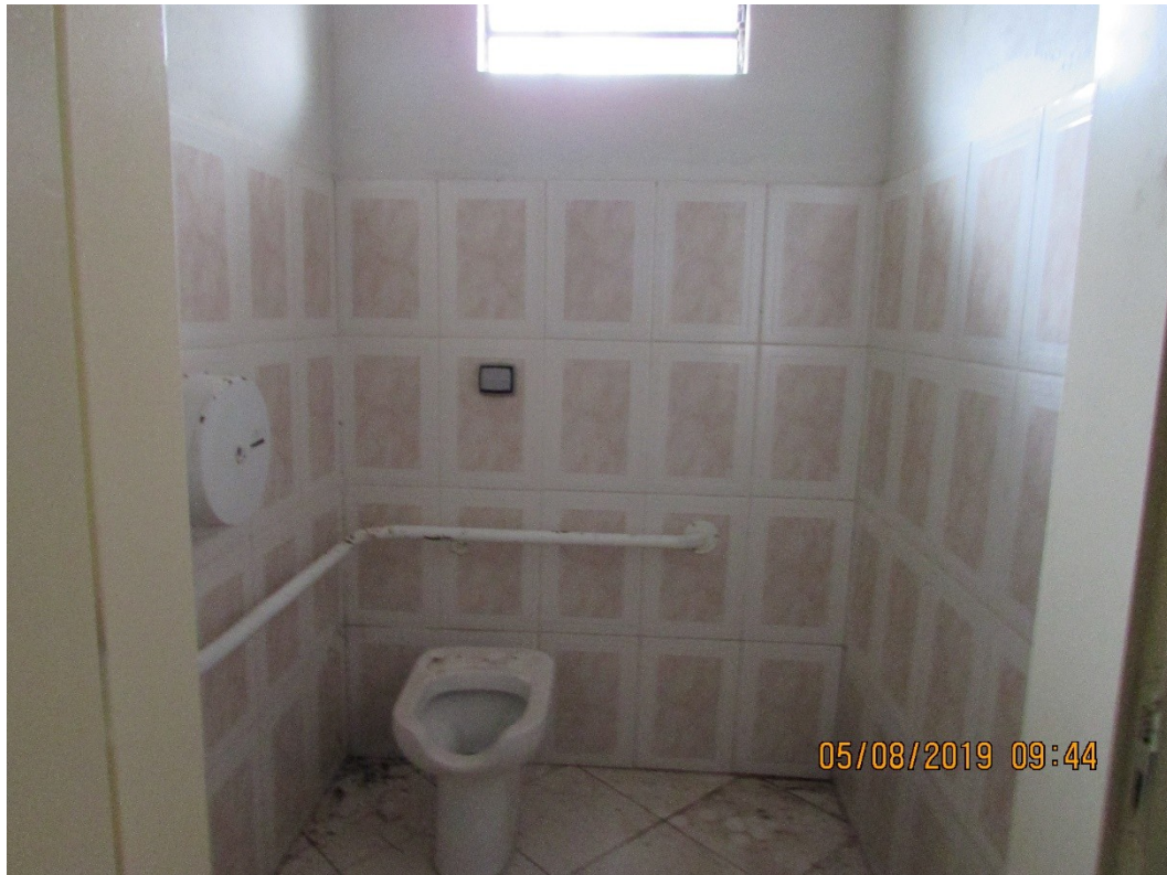
Foto 4: Recuperação dos sanitários.
