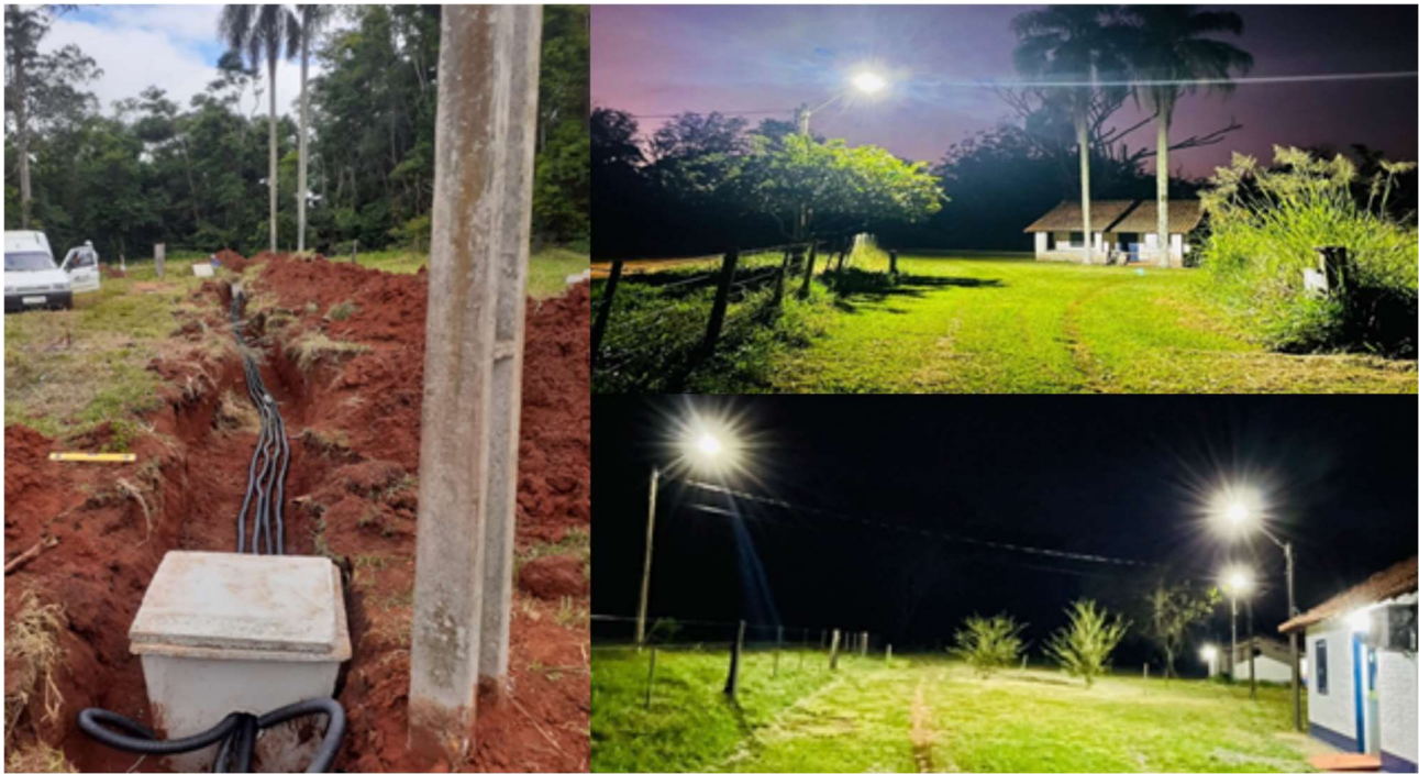
Figura 11. Restruturação elétrica, fibra óptica e iluminação (Atlética; Almojarifado, Needs, Sítio Agroecológico)
