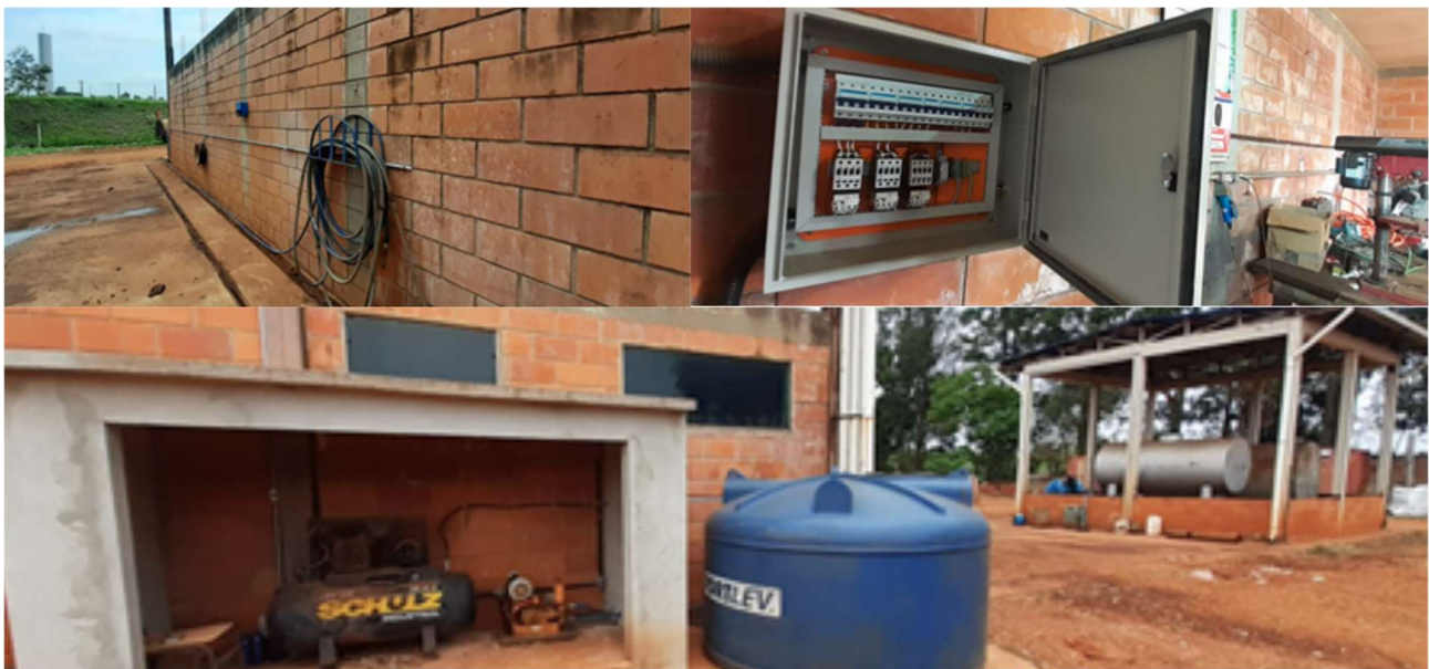
Figura 12. Melhorias na oficina
