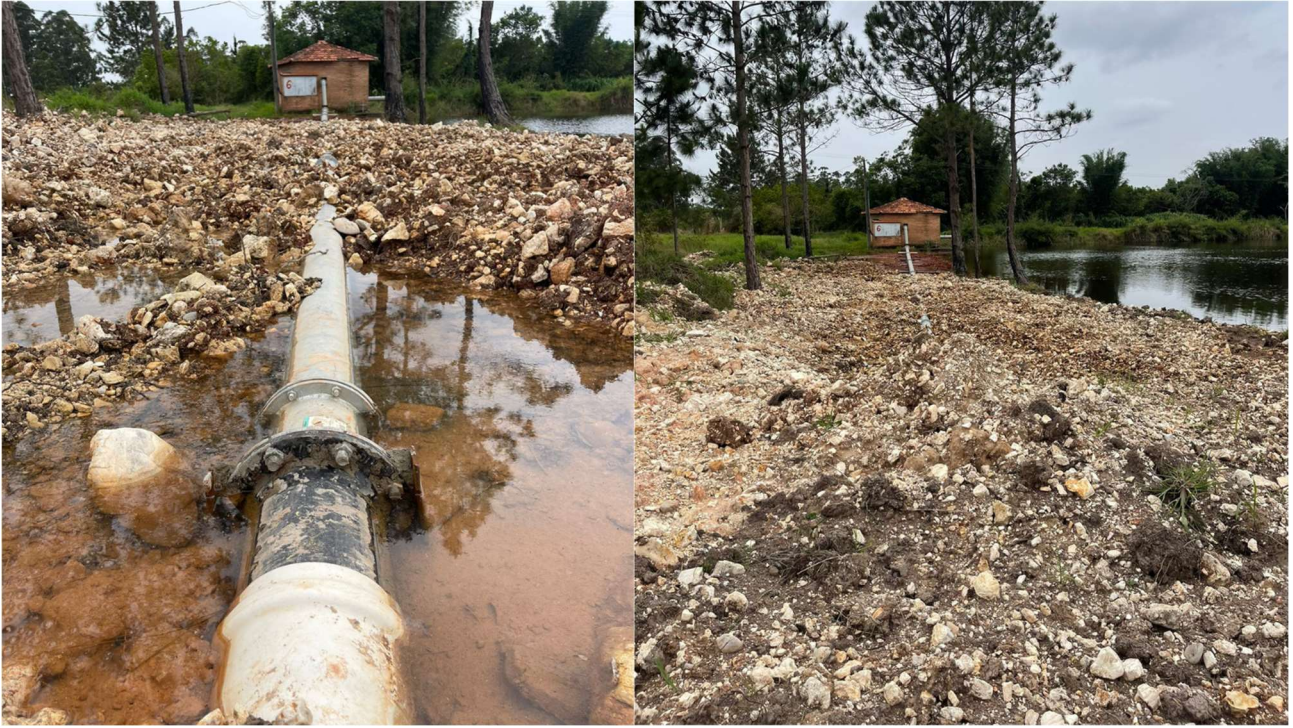
Figura 21. Troca da adutora do pivô 3.
