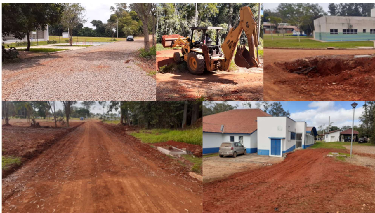
Figura 19. Operações com a retroescavadeira
