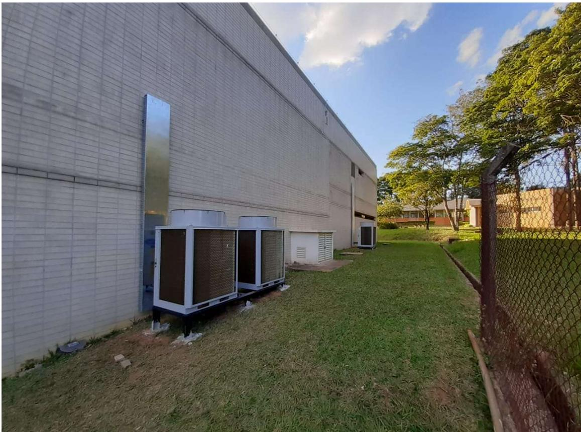
Figura 8 – Chillers instalados.
