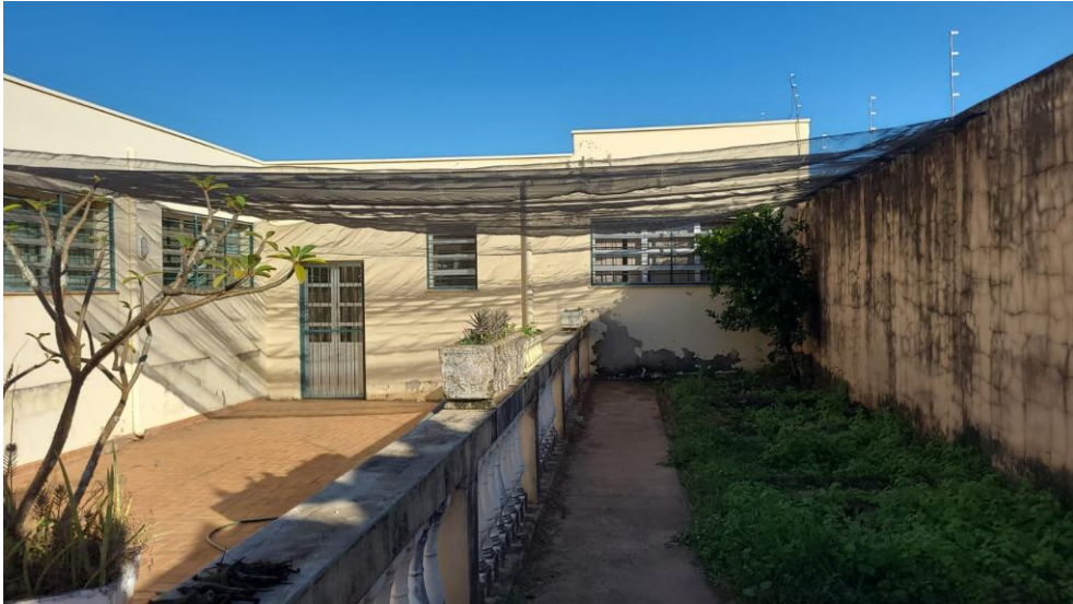
Figura 3: Instalação do sombrite na área.
